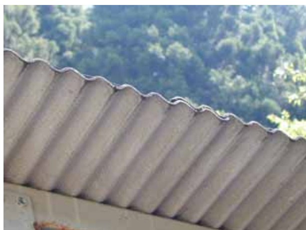
写真 2 スレート波板
