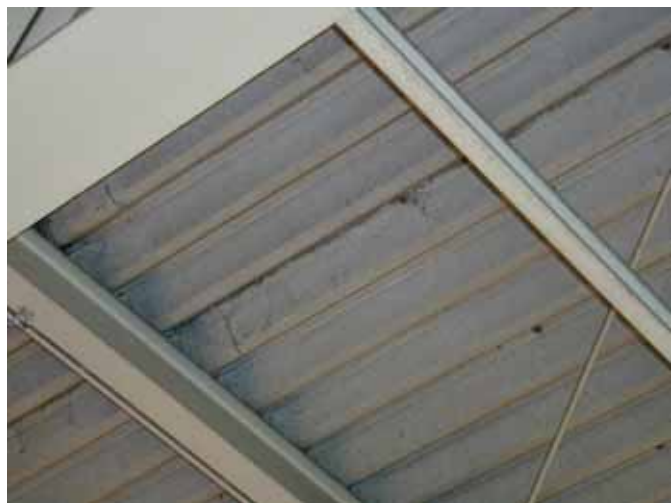
写真 1 屋根用折版裏断熱材
